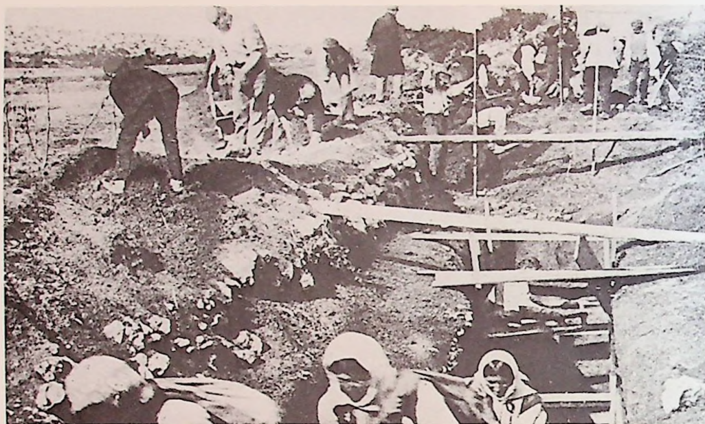
Asanacione radnje – pod vodstvom Zavoda provodila se borba protiv malarije. Jedan od vidova suzbijanja malarije je bilo izvođenje većih i manjih asanacionih radova (uređivanje kanala, lokava i baruština, čišćenje jaruga, te drugih objekata gdje se drže ličinke komaraca).
