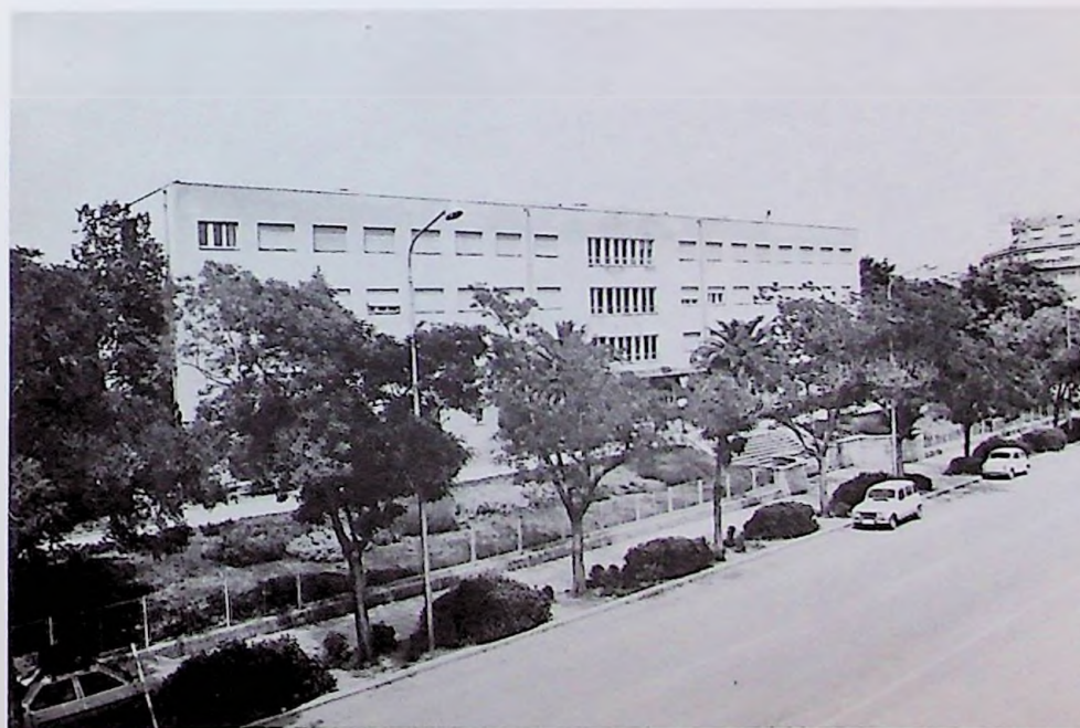
Zgrada primarne zdravstvene zaštite
