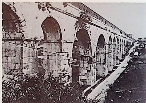
Ostaci Dioklecijanovog vodovoda
