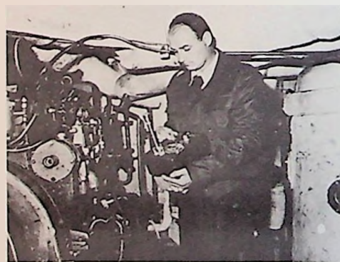
Iz rada Instituta, ispitivanje buke na ratnom brodu.
