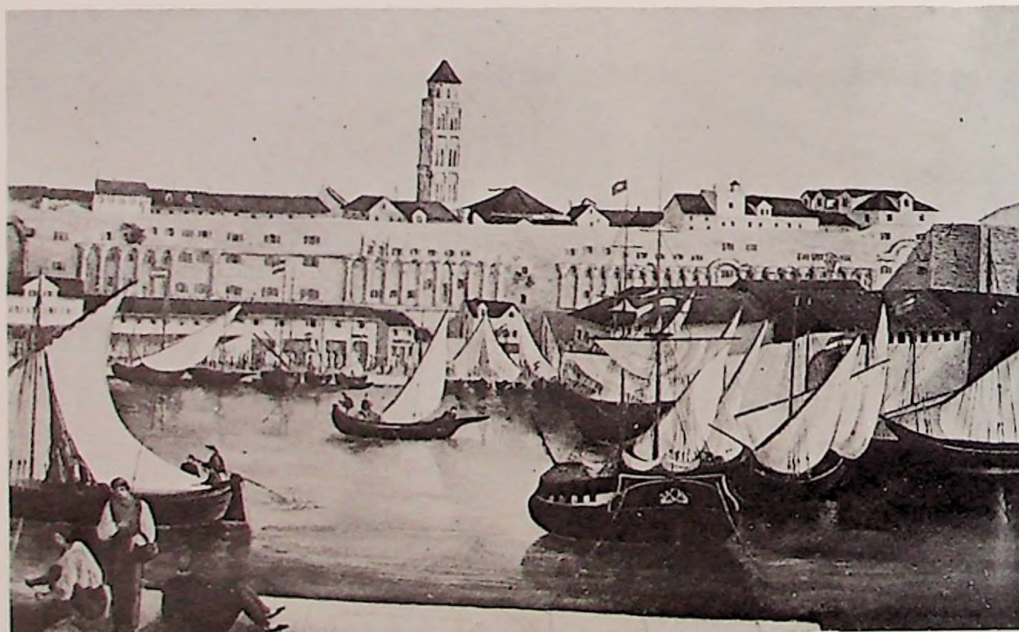
Pročelje Lazareta i Dioklecijanove palače, akvarel dra Franje Bratanića, ravnatelja gradske bolnice u Splitu.
