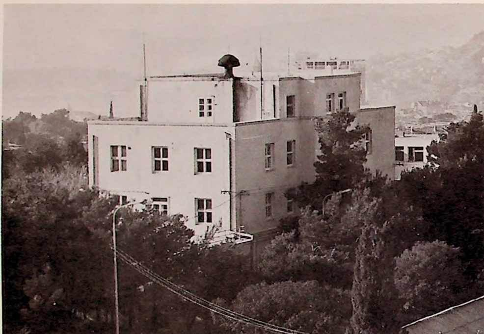
Zavod za zaštitu zdravlja – od 1933. godine. Zavod se nalazi na sadašnjoj lokaciji na Gričama.
