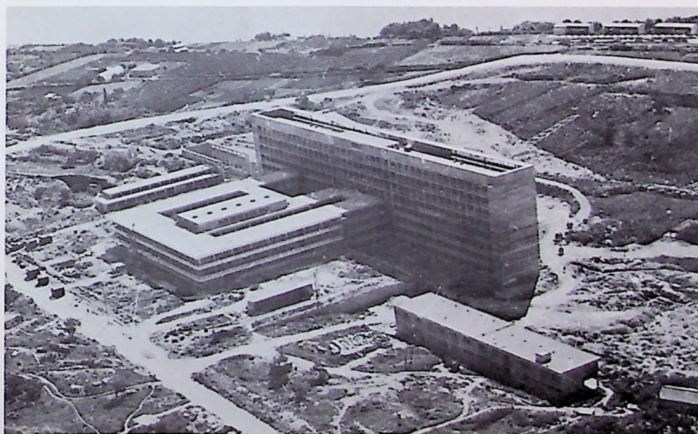
Kompleks nove Vojne bolnice 1964. g. u izgradnji.
