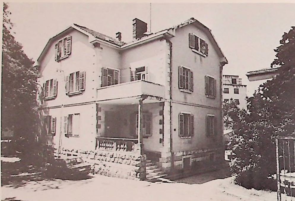
Stara zgrada Higijenskog instituta MC RM u Ivanovićevoj ulici u Splitu.
